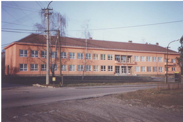
Obr. č. 4 Základní škola a Hotelová škola Mikulov, s.r.o., v obci Sedlec
