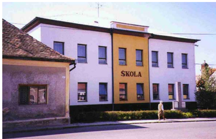
Obr. č. 3 Základní škola (odloučené pracoviště ZŠ Dolní Dunajovice) v obci Perná
