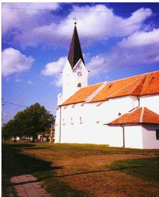
Obr. č. 11 Nový Přerov – kostel sv. Michala
